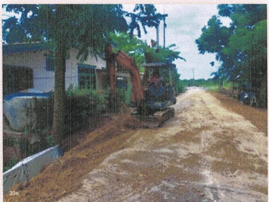
จ้างเหมาขุดลอกตะกอนดินภายในรางระบายน้ำคสล. ซอยบ้านเกาะสามัคคี หมู่ที่ 2
