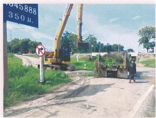
จ้างเหมาเสริมผิวลูกรังไหล่ทางถนนซอยศรีธาสำคคี หมู่ที่ 3
